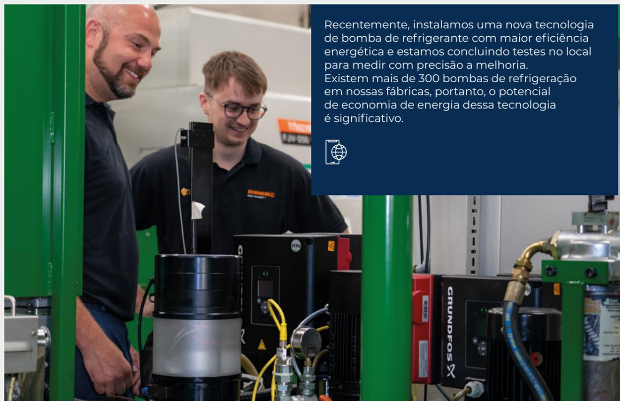
Recentemente, instalamos uma nova tecnologia de bomba de refrigerante com maior eficiência energética e estamos concluindo testes no local para medir com precisão a melhoria. Existem mais de 300 bombas de refrigeração em nossas fábricas, portanto, o potencial de economia de energia dessa tecnologia é significativo.
