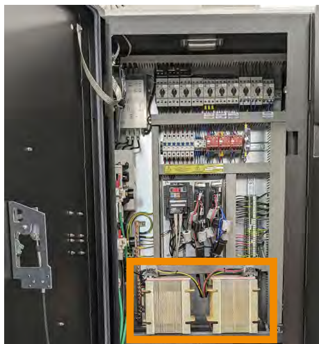
Abbildung 70 Zwei Transformatoren im hinteren linken Schaltschrank
