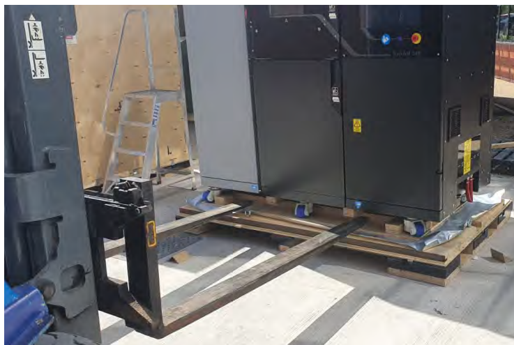
Abbildung 62 Gabel an den Kennzeichnungen der Gabelstapler-Hebepunkte ansetzen
