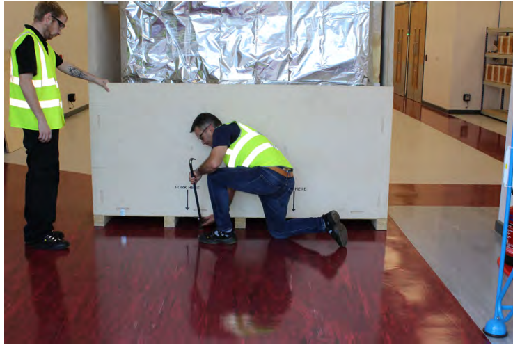
Abbildung 49 Halten und die Befestigungsklammern der vorderen unteren Platte entfernen
