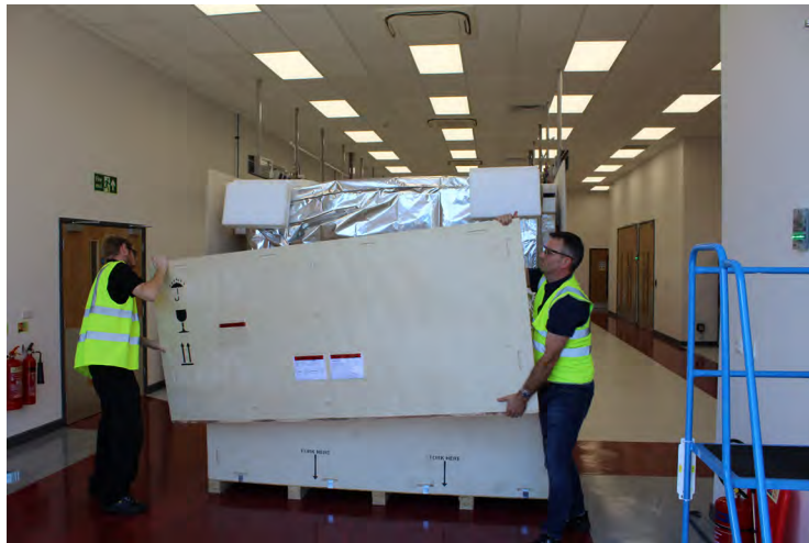
Abbildung 48 Die vordere obere Platte abnehmen
