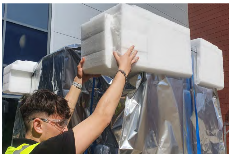
Imagen 58 Retirando las esquineras de espuma
