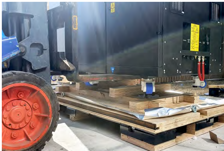
Imagen 63 Elevando el sistema hasta que la base se despegue de la caja
