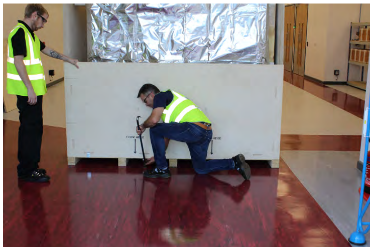
Imagen 49 Soporte y retirada de las pinzas del panel delantero inferior
