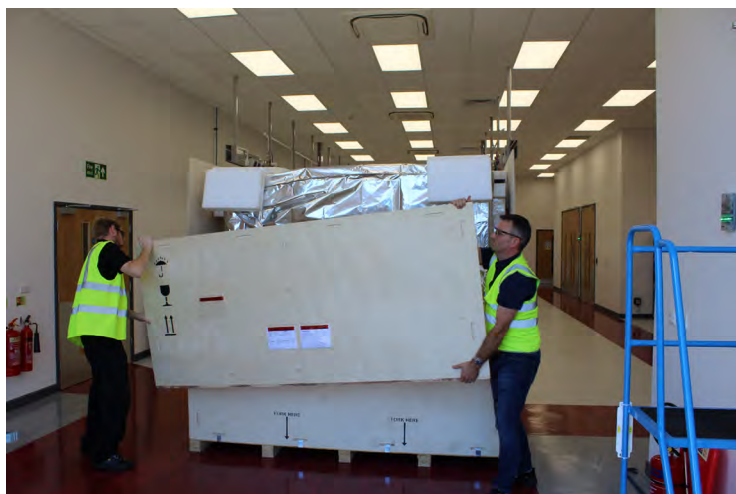
Imagen 48 Retirando el panel delantero superior
