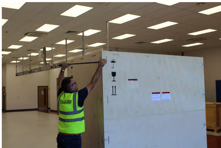
Imagen 47 Retirando las cuatro pinzas que fijan el panel superior delantero
