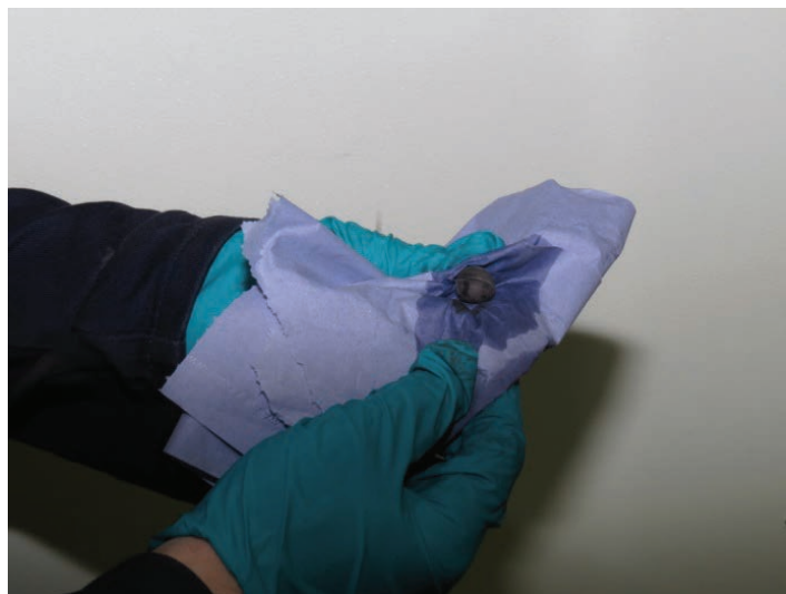
Figura 37 Limpe as esferas PRS com IPA Classe 3
