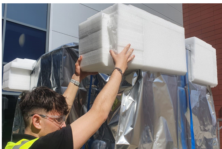
Figure 58 Retirez les coins d'emballage en mousse
