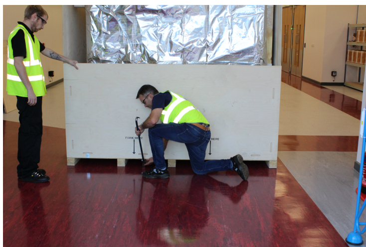
Figure 49 Soutien et retrait des clips du panneau inférieur avant
