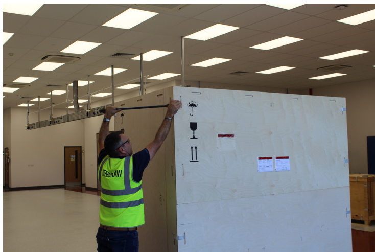
Figure 47 Retirez les quatre clips qui fixent le panneau supérieur avant
