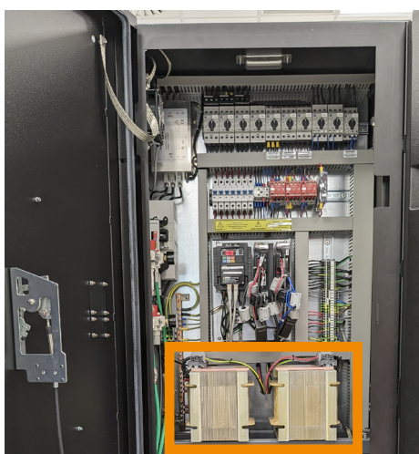
Figure 70 Deux transformateurs dans l'armoire électrique arrière gauche
