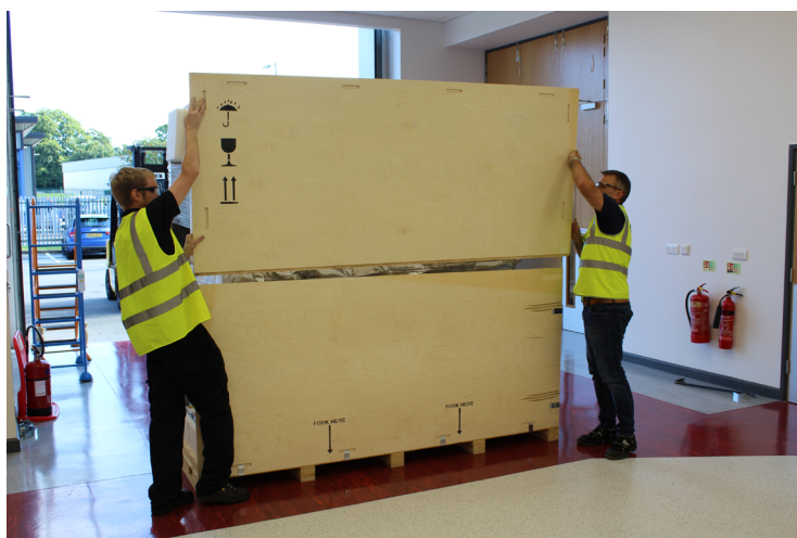
Figure 52 Retrait du panneau supérieur arrière
