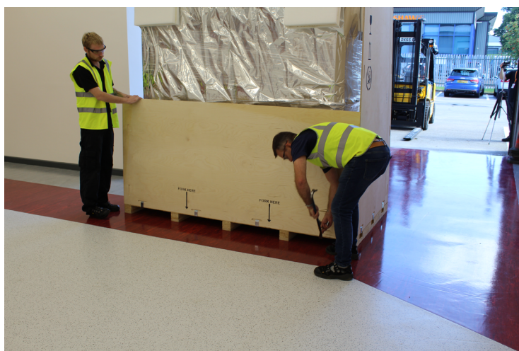
Figure 53 Soutien et retrait des clips du panneau inférieur arrière
